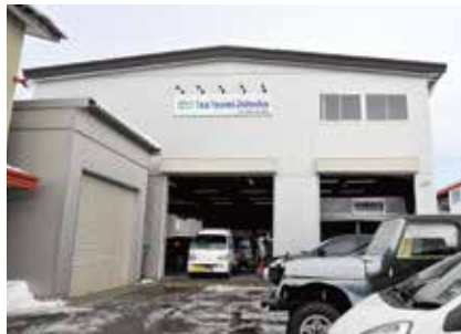
機能的に設計された修理工場
